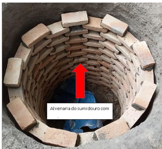
Tubo concreto (h=0,50m) de sustentação da parede do
